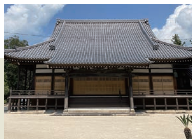
石原建築が施工した山口県の景好寺本堂
