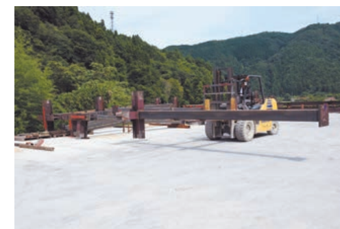
鉄骨の出荷作業
