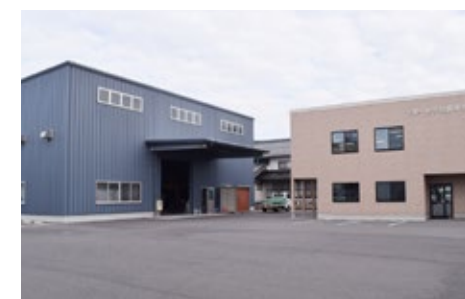
松栄設備の全景
