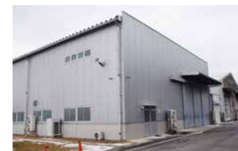
29年に完成した新工場
