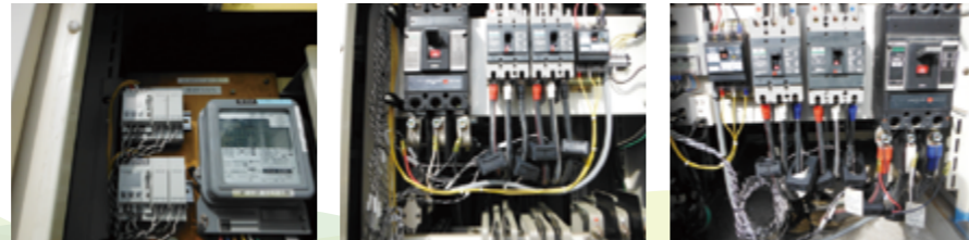
計測機器取付け状況
